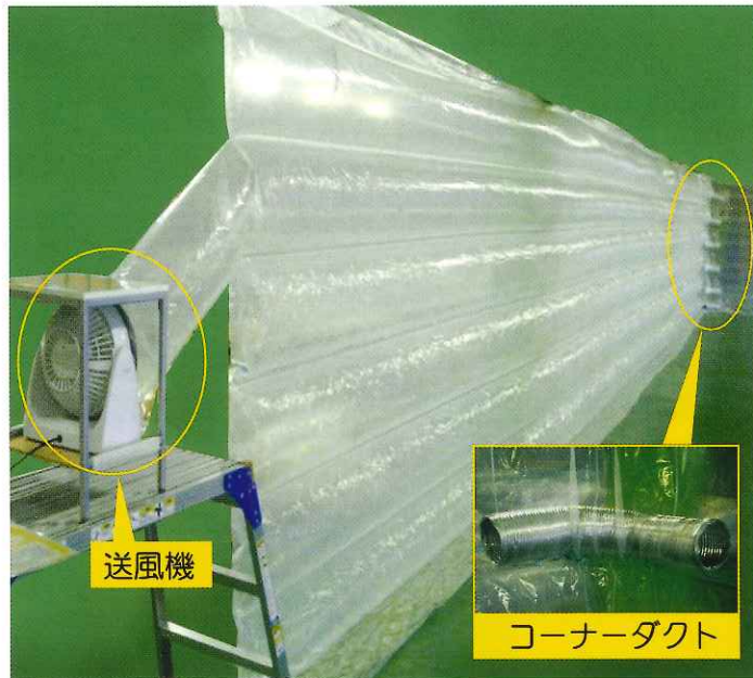
◆左事例1の上段換気が開いた状態
